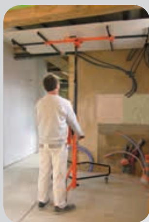
Pose horizontale jusqu'à 4,50 m
