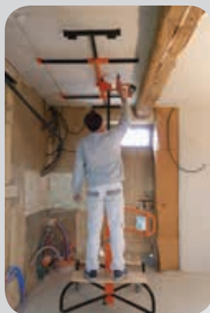
Pose horizontale jusqu'à 4,50 m
