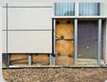
Isolation par laine minérale avec bardage
