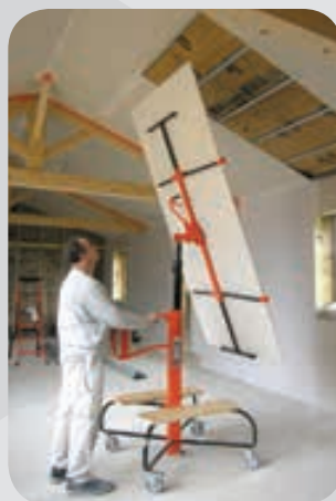
Pose sous rampants
