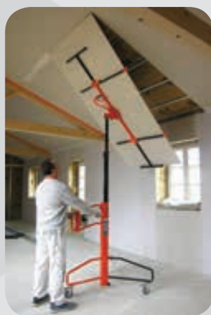
Pose sous rampants
